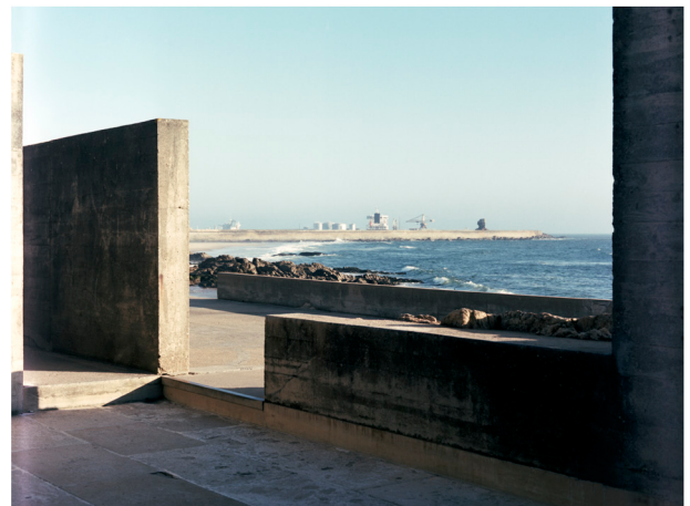
Obra de Álvaro Siza Piscinas de marés, Matosinhos . foto Nuno Cera
